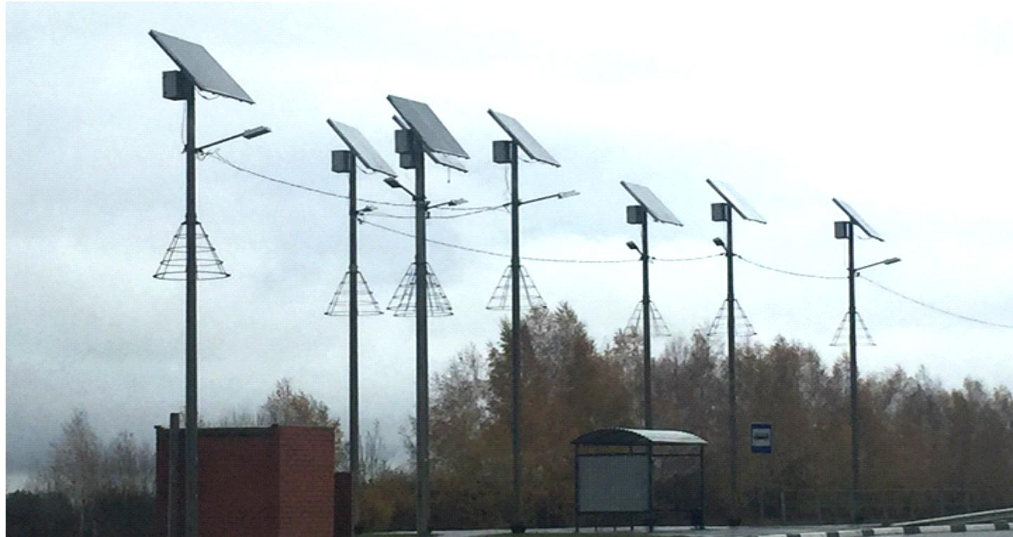
Для обеспечения безопасности на автодорогах за счет стабильной светимости АОС на протяжении круглого года недостаточно просто подобрать сопутствующие комплектующие и скомпоновать из них систему, опыт показывает, что спроектированные таким образом системы зачастую не способны сохранять светимость в зимний период.
